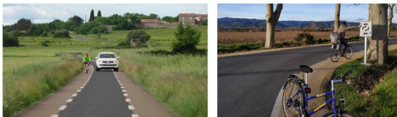
Exemples (Département de l'Hérault) de réduction visuelle de chaussée, avec marquage de continuités cyclables et piétonnes, en bordure d'une route rurale. Cette intervention minimale permet à la fois d'indiquer la priorité des modes doux sur les voitures et de faire ralentir les automobilistes, qui se voient contraints de ralentir et de se céder le passage pour se croiser, le tube central étant réduit à la largeur d'une seule voie (3 à 4 mètres).
