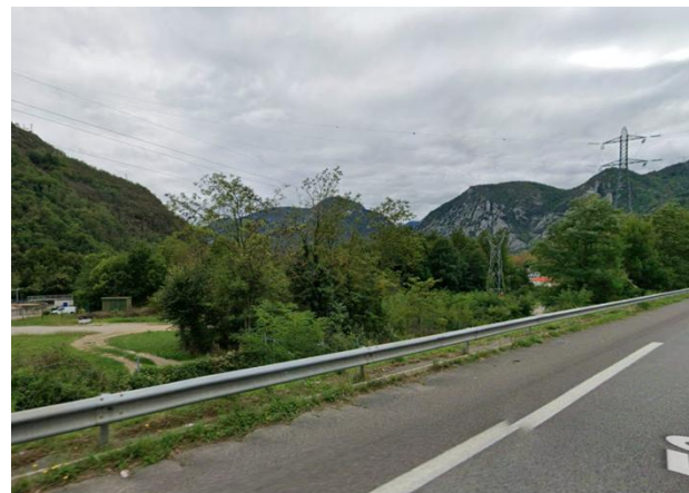
Vue N°6 : vue sur la station d'épuration
