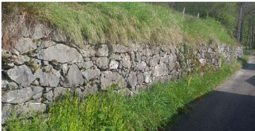
Figure 50 : Muret protégé propice aux reptiles
