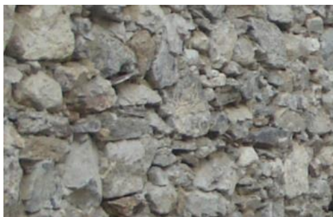
Mur en pierre brute hordée
