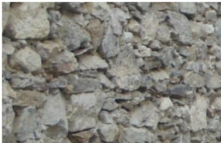
Mur en pierre brute hordée
