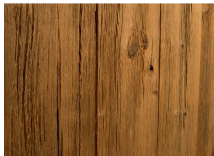
Mur en bardage bois
