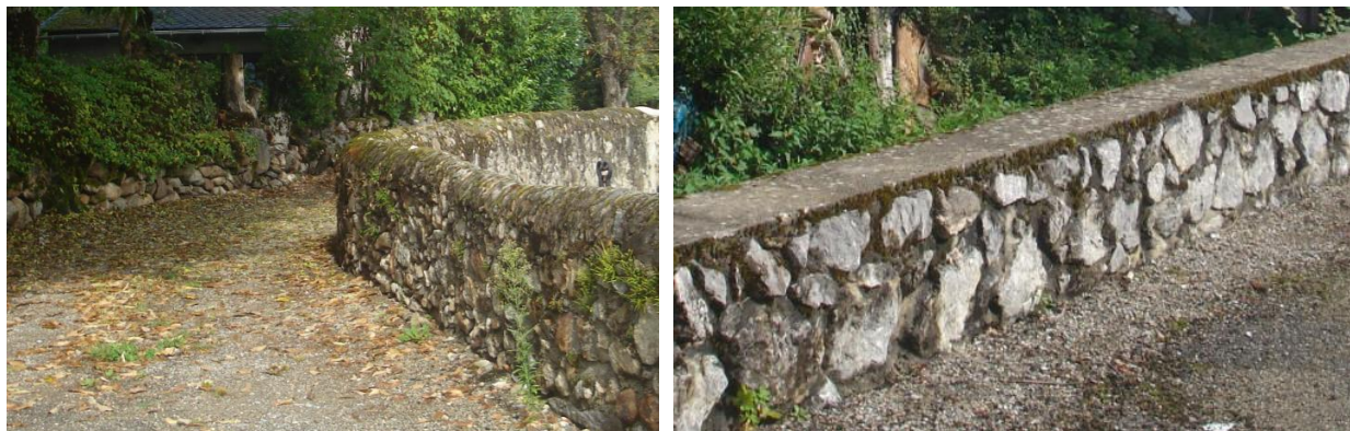
Muret en pierre
