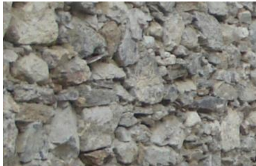
Mur en pierre brute hordée
